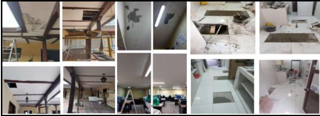
Ilustración No. 7. Evidencia Fotográfica mantenimiento Sede D.T Cauca abril 2022
