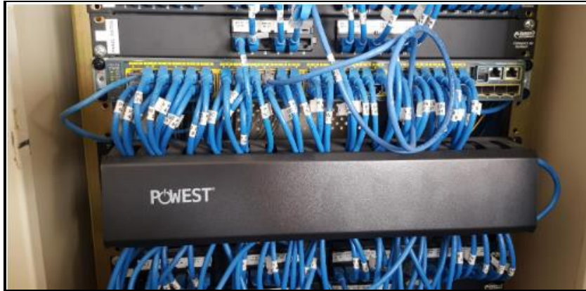
Ilustración No. 13. Marquillado rack de Comunicaciones
