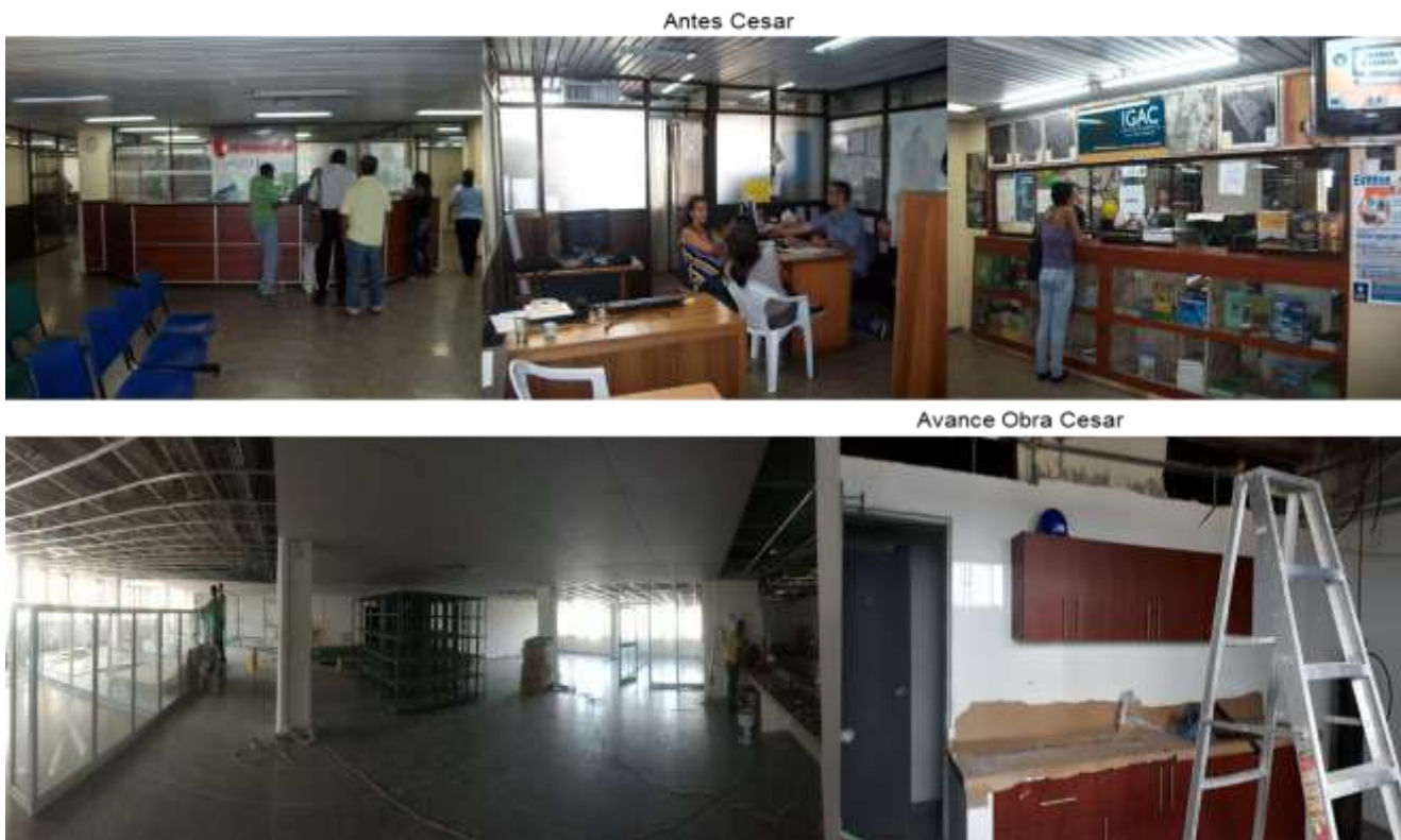
Ilustración 109. Registro fotográfico de Cesar (en finalización obra)
